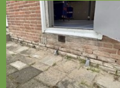
Niveaueverschil 48cm - Vluchtveiligheid
