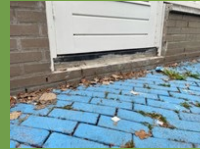
Niveaoverschil 19cm - Vluchtveiligheid
